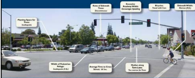
El Camino Real @ Los Robles - EXISTING CONDITIONS
